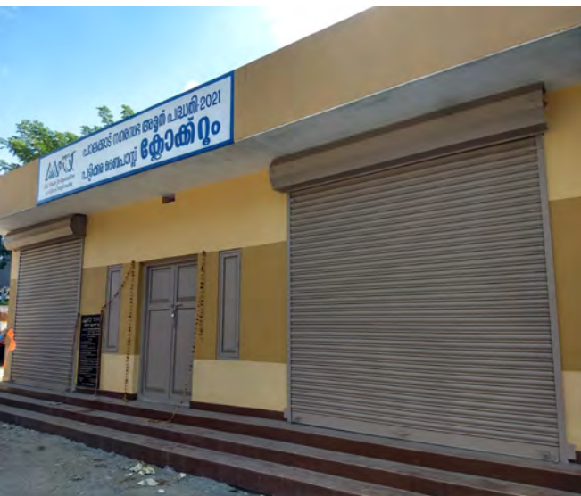
പട്ടിക്കരയിൽ നിർമ്മാണം പൂർത്തിയായ ക്ലോക്ക് റൂം
